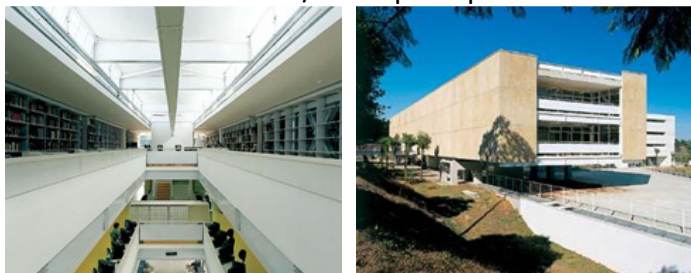
Figuras 6 e 7- Biblioteca Central da PUC – Vista Interna/Bloco principal
